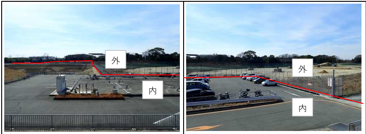
No1 処分場のフェンスライン 地番界及び敷地外周フェンスライン
