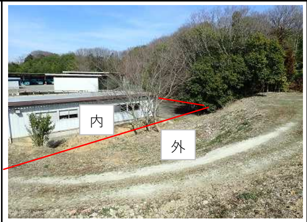
No16 擁壁の延長ライン
