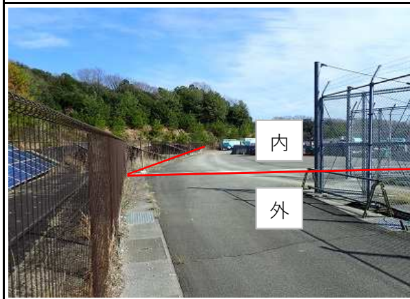
No5 処分場フェンスの延長ライン 太陽光フェンスライン
