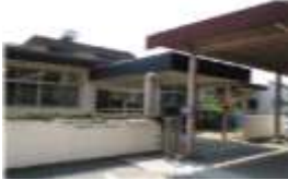
施設外観写真
