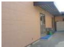
施設外観写真
