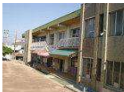
施設外観写真
