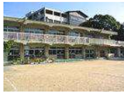
施設外観写真
