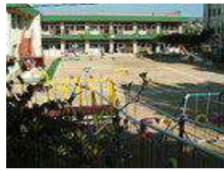
施設外観写真
