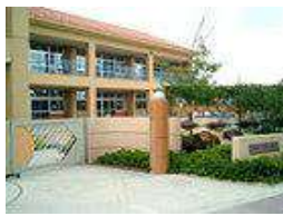
施設外観写真
