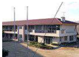
施設外観写真
