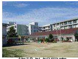
施設外観写真
