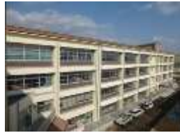
施設外観写真
