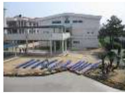
施設外観写真
