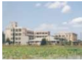
施設外観写真
