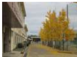
施設外観写真
