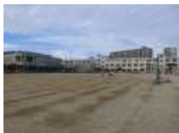
施設外観写真
