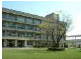
施設外観写真
