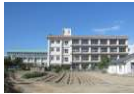
施設外観写真
