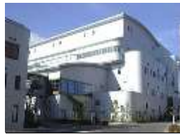
施設外観写真
